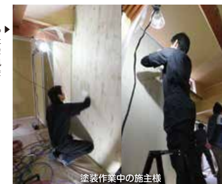
塗装作業中の施工様
